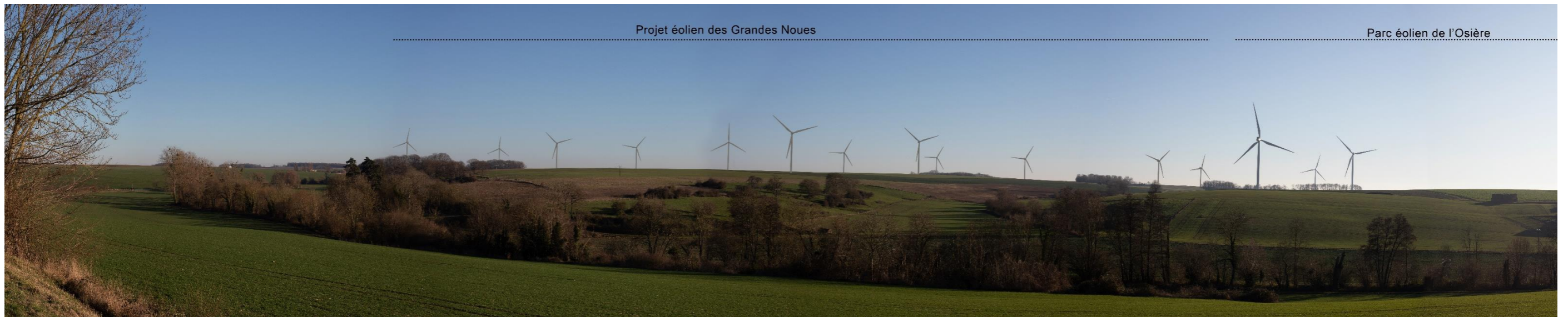
Photomontage 6_Entrée/sortie de Remontvoisin_120°_B_représentation réelle des éoliennes visibles du projet éolien des Grandes Noues
