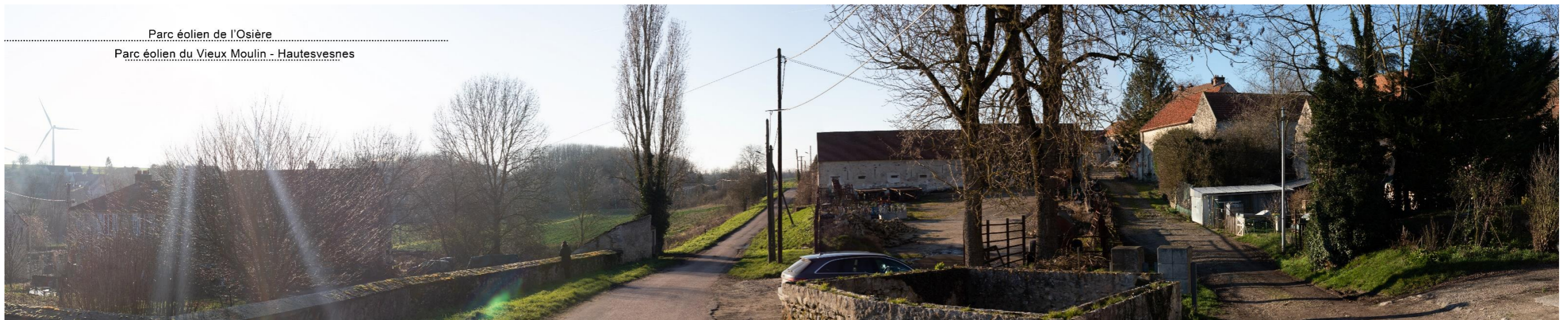
Photomontage 5_Centre-bourg de Remontvoisin_120°_C_représentation réelle des éoliennes visibles du projet éolien des Grandes Noues
